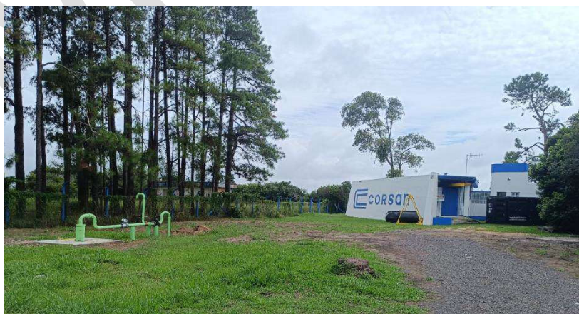
Figura 19 – ETA Poço e casa de bombas.
