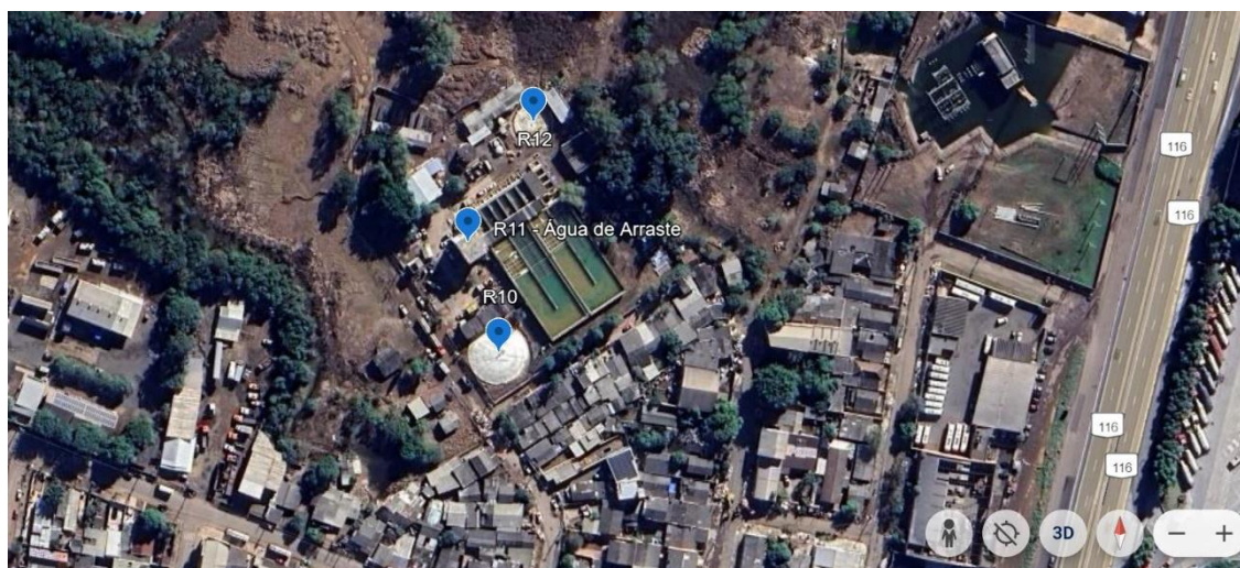
Figura 24 – Pontos vulneráveis SAA/Reservatórios da ETA.
