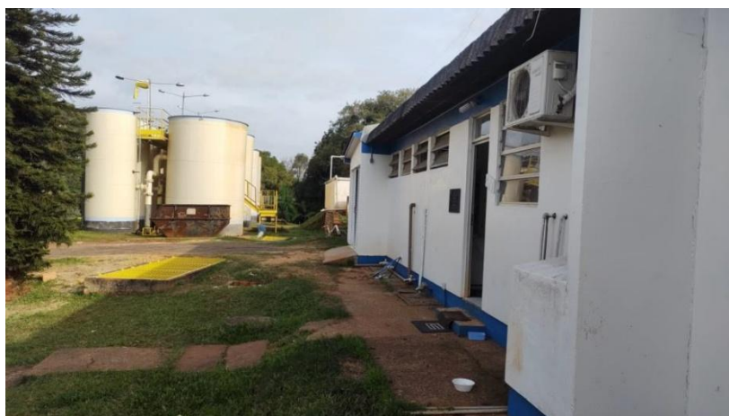
Figura 20 – ETA Santo Antônio da Patrulha.
