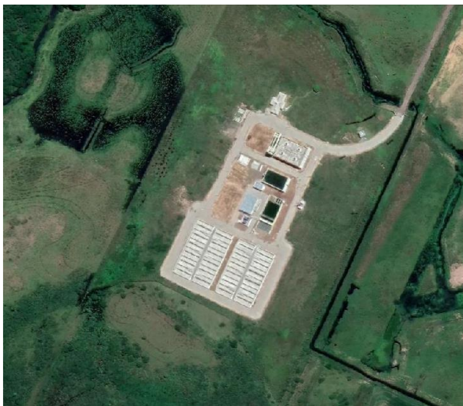
Figura 37 – Localização da ETE Santo Antônio da Patrulha.
