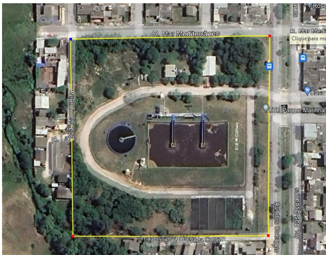
Figura 27 – Vista aérea da ETE Parque Marinha.
