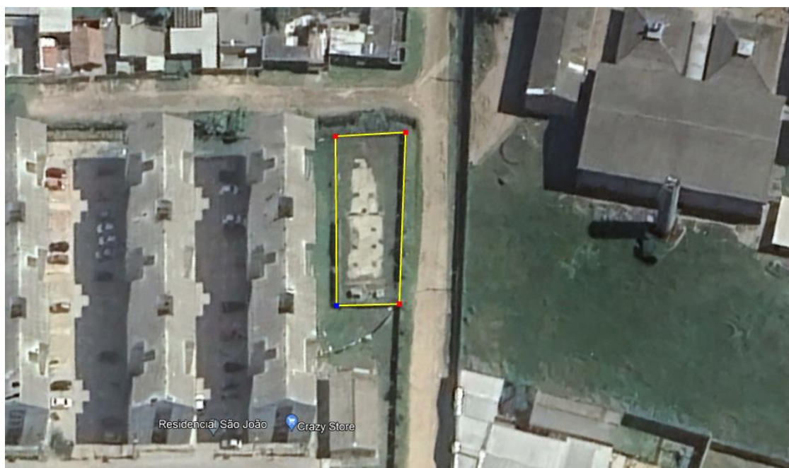
Figura 29 – Vista aérea da ETE São João.
