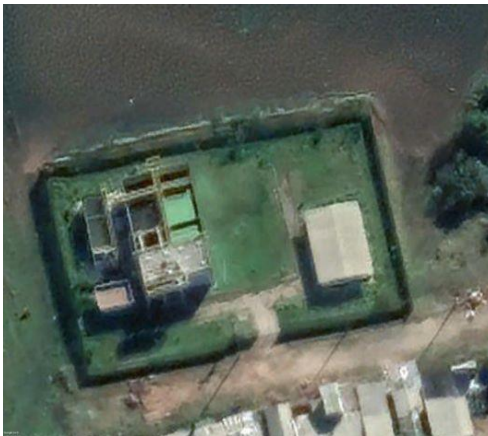
Figura 27 – Vista da ETE Ponta de Figueira.
