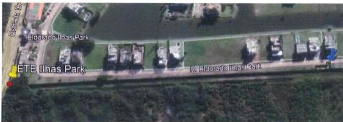
Figura 32 – Vista do SES Ilhas Park.
