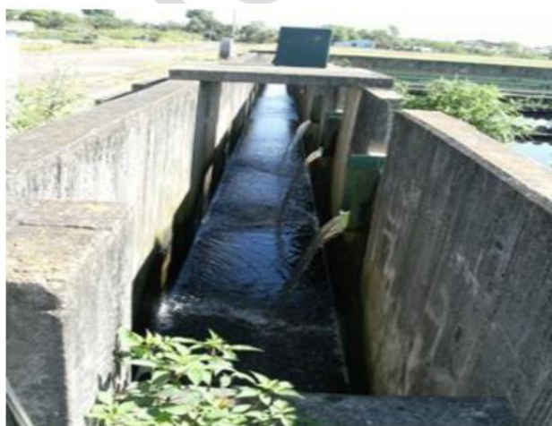
Figura 24 – Saída do efluente líquido e do canal com o efluente final, que conduz o líquido tratado à vala de drenagem do Polder Rio Branco.
