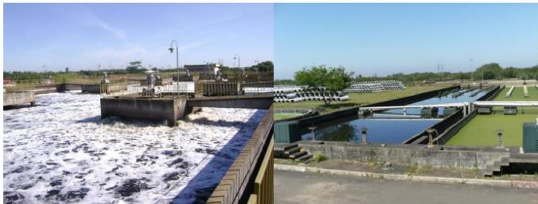
Figura 23 – Unidades do Tratamento Secundário da ETE Mato Grande – Reator de lodos ativados (à esquerda) e Decantador (à direita).
