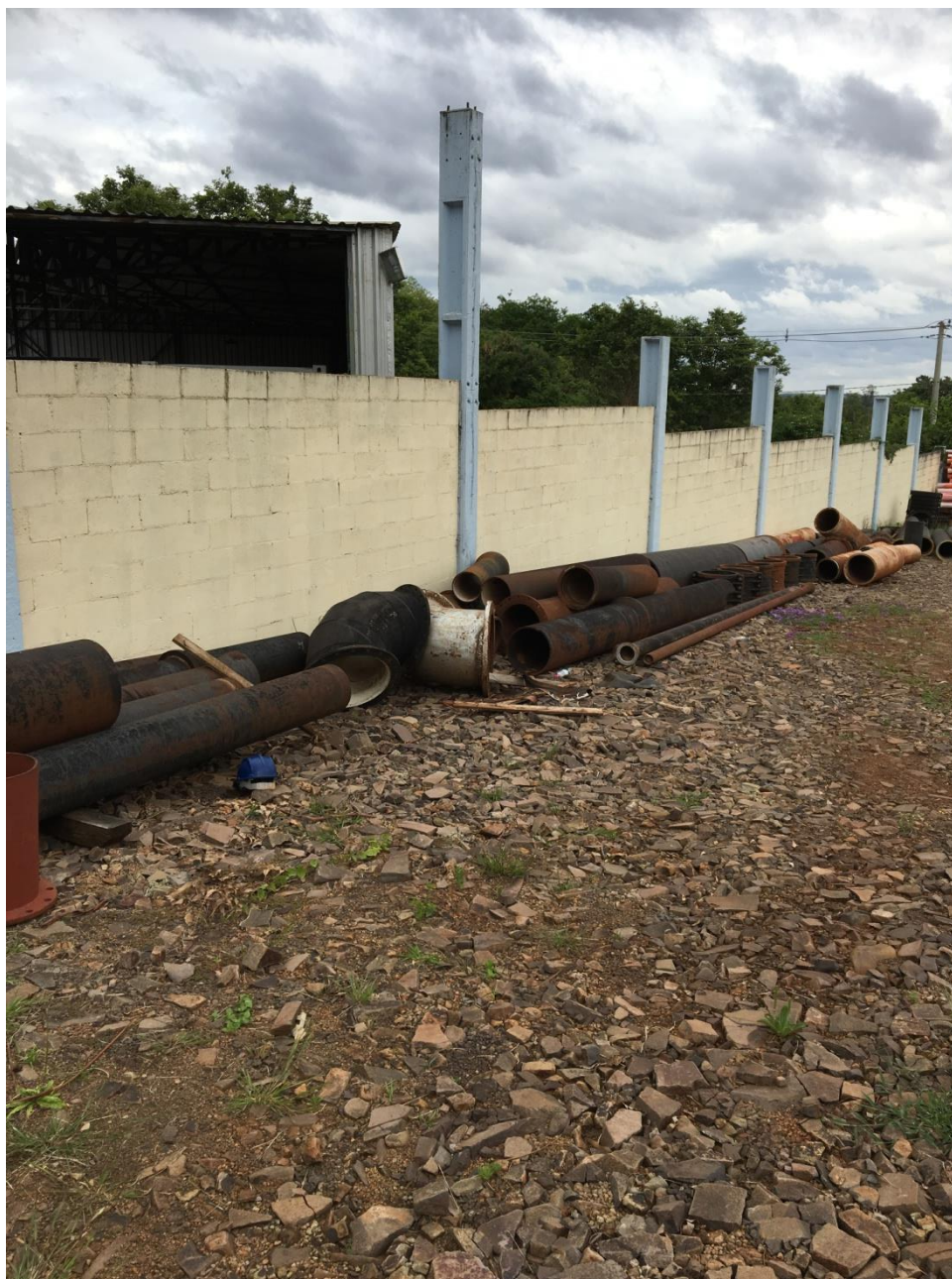
Foto 14 - Material de Manutenção
