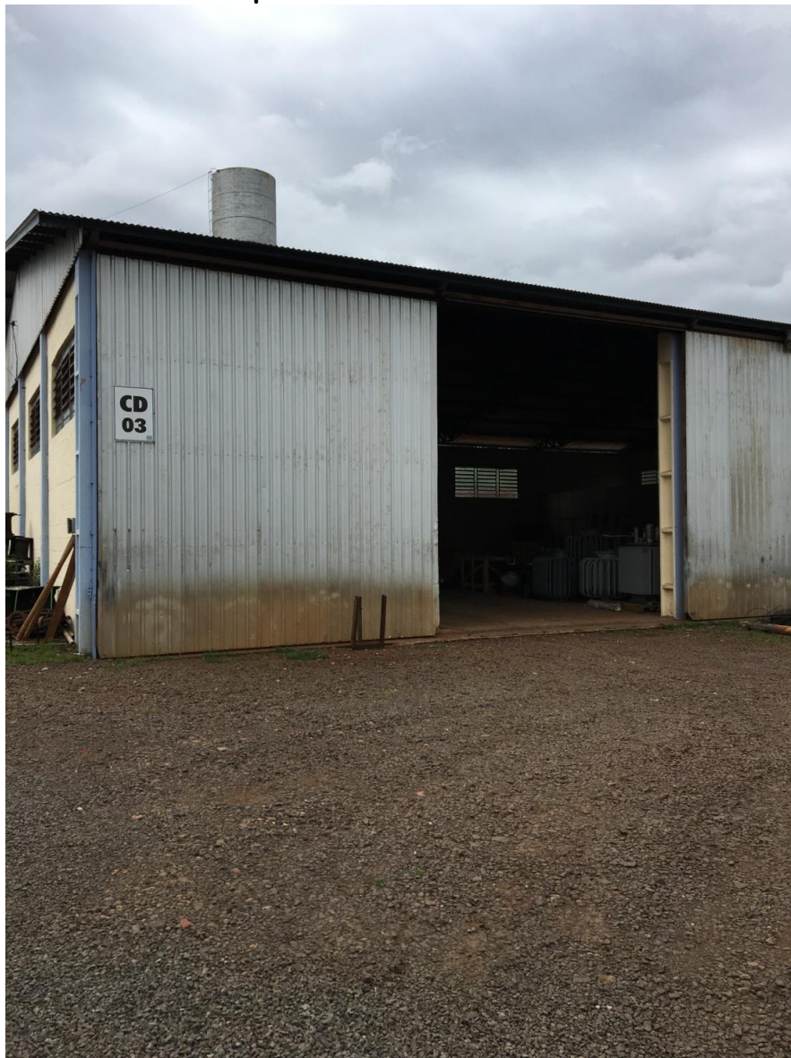
Foto 6 - Depósito de Bens Patrimoniais
